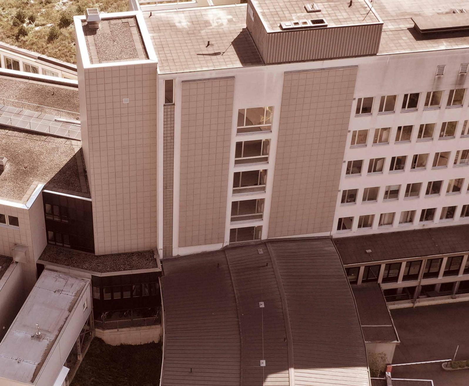
Flachdach saniert. Ausserdem wird das Gebäude auf den neusten Stand der Erdbebensicherheit gebracht. Zusätzlich erhält das Haus D auf dem Flachdach eine Fotovoltaikanlage, welche vom Stromlieferanten betrieben wird. Der produzierte Strom soll zu 100 Prozent direkt als Eigenverbrauch vom KSU genutzt werden.
